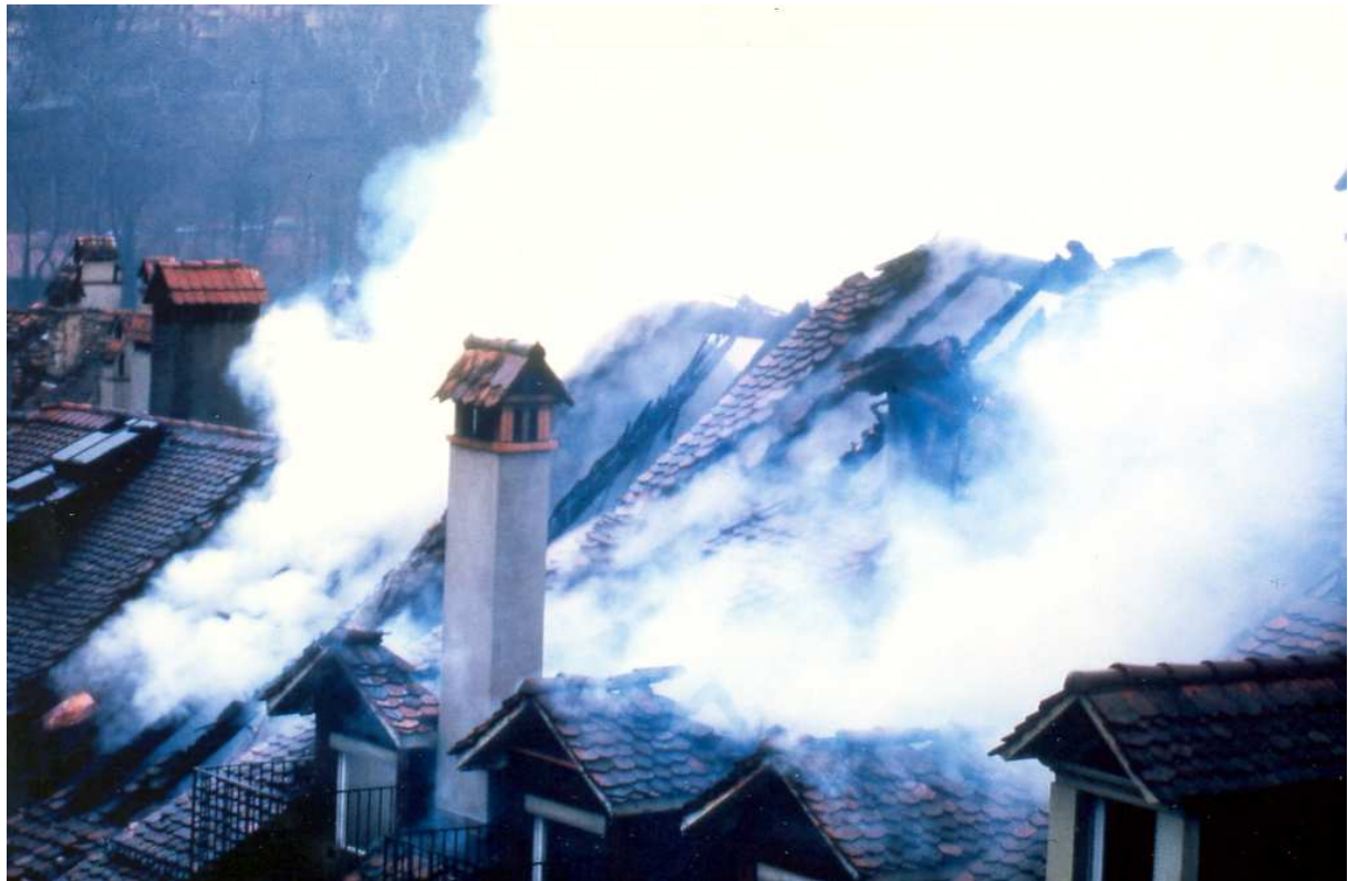
Ein unvergessener Anblick: fünf Altstadt Häuser ein Raub der Flammen... dazu auch ein Video-Dokument unter Google: altstadtbrand bern
