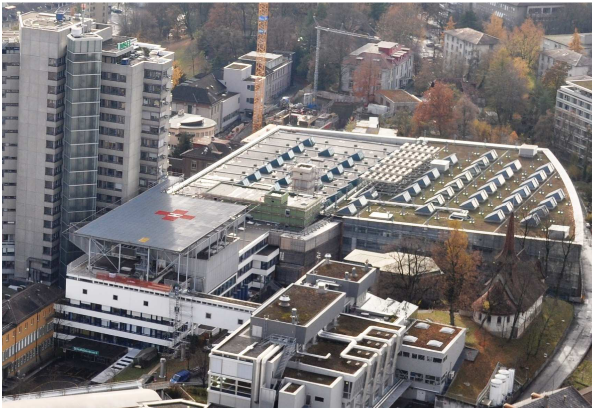
Ein gewichtiges Beschaffungsobjekt der Kategorie KOMPLEX mit Geschichte kurz vor der Fertigstellung anfangs 2011: Das INO Intensivbehandlungs-, Notfall- und Operationszentrum der Insel.
