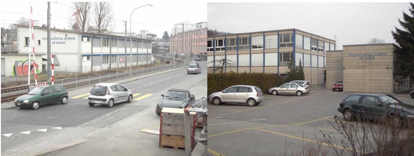
Die eingeeengte Lage im Industriequartier Gümligen passt nicht optimal zum Erscheinungsbild einer International School.
