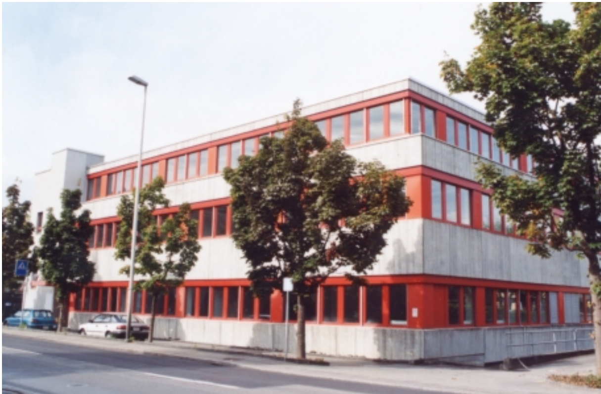
Bild: Was stimmt hier nicht? Das Erdgeschoss muss auf Grund des Nutzungszonenplans leer bleiben!
