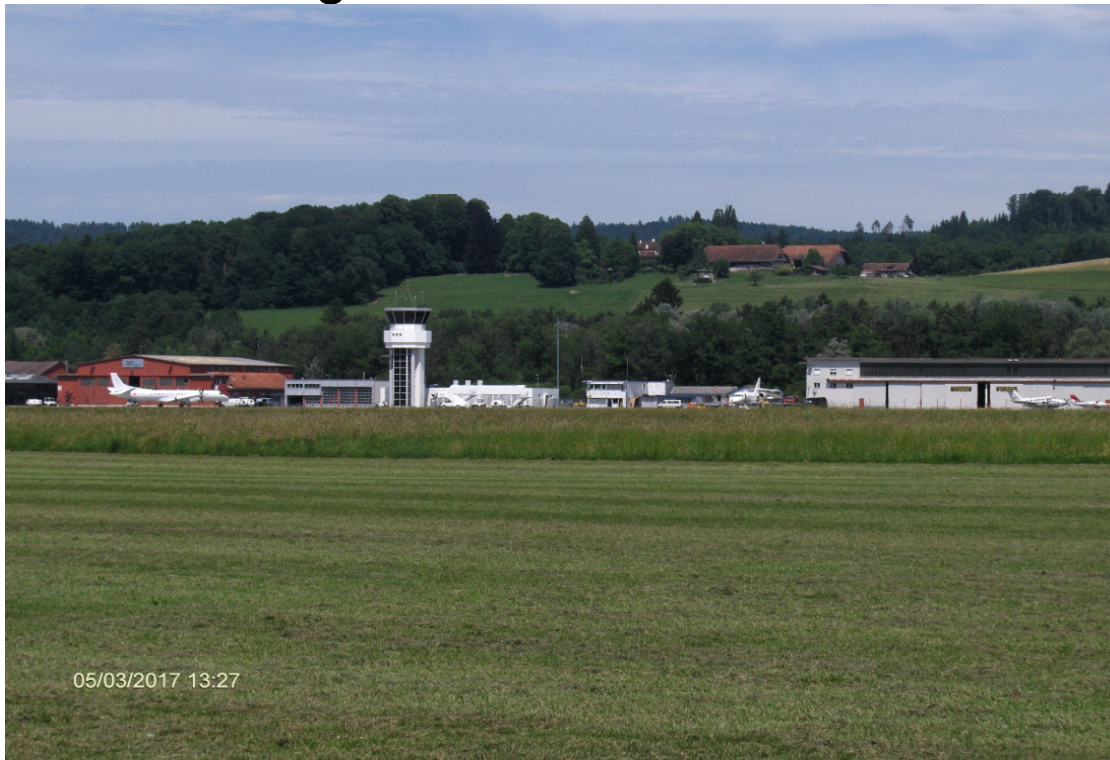
Sicht vom künftigen Hangarstandort auf die jetzige Flughafenanlage.
