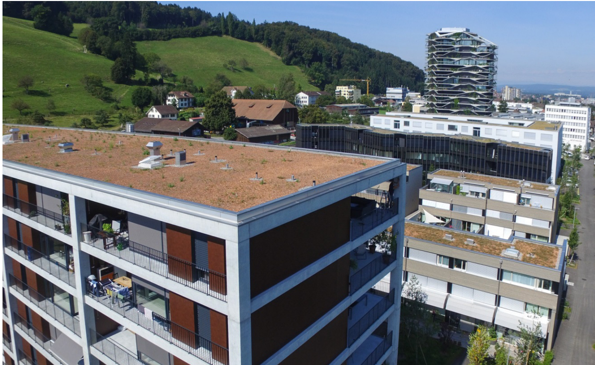
Bächtelenpark 2016: Hier sind nach einer optimalen Projektentwicklung 200 Wohnungen und 550 m 2 Gewerbefläche erbaut worden. (Quelle: Priora AG, Generalunternehmung)
